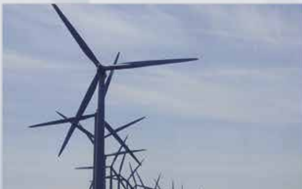
Beleuchtungsmasten und Masten für Windanlagen
